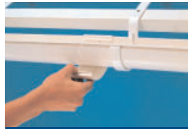
Monter skjøtestykke.
