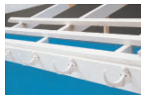
Monter rennekrokene.
