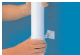
Montering av rørfeste.
