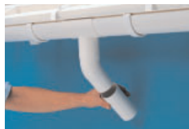
Montering av fallrør.
